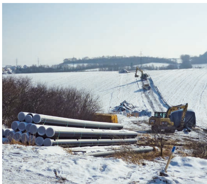
Brandýsek, Stehelčevy – okr. Kladno Výtlačný řad ZV Theodor, rekonstrukce vodovodu DN500 – technologie Relining
