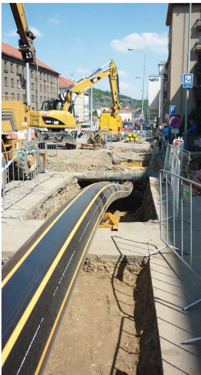
Praha 6, ul. Podbabská Oprava STL plynovodu DN500 – technologie DynTec
