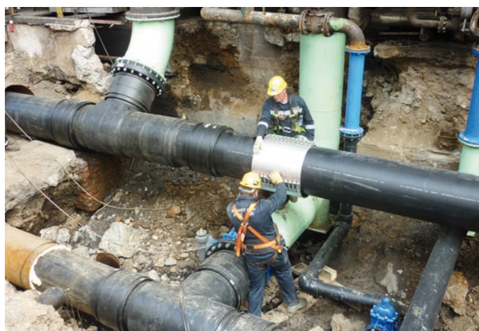
Česká Rafinérská, a.s. – Litvínov Rekonstrukce potrubí chladicí vody DN400, DN200 (CCR+AVD) technologie Relining
